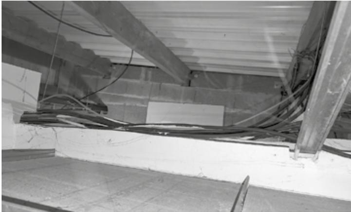
En ces temps de coûts exorbitants de l'énergie c'est une très mauvaise surprise. De plus, un courant d'air permanent circule dans le faux-plafond et la condensation qui se forme sur les conduits de VMC goutte sur les dalles de faux-plafond jusqu'à les détruire.
